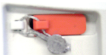
Блокировка включена и опломбирована проволочной пломбой
